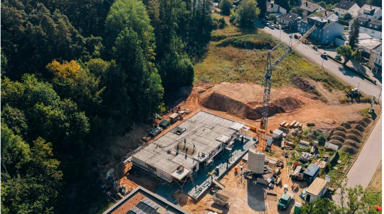
Luftbild Juli 2026: das Baufeld am Waldrand, im Hintergrund Weiden. Links das bereits fertiggestellte Nachbargebäude. Foto: Luca Donth
