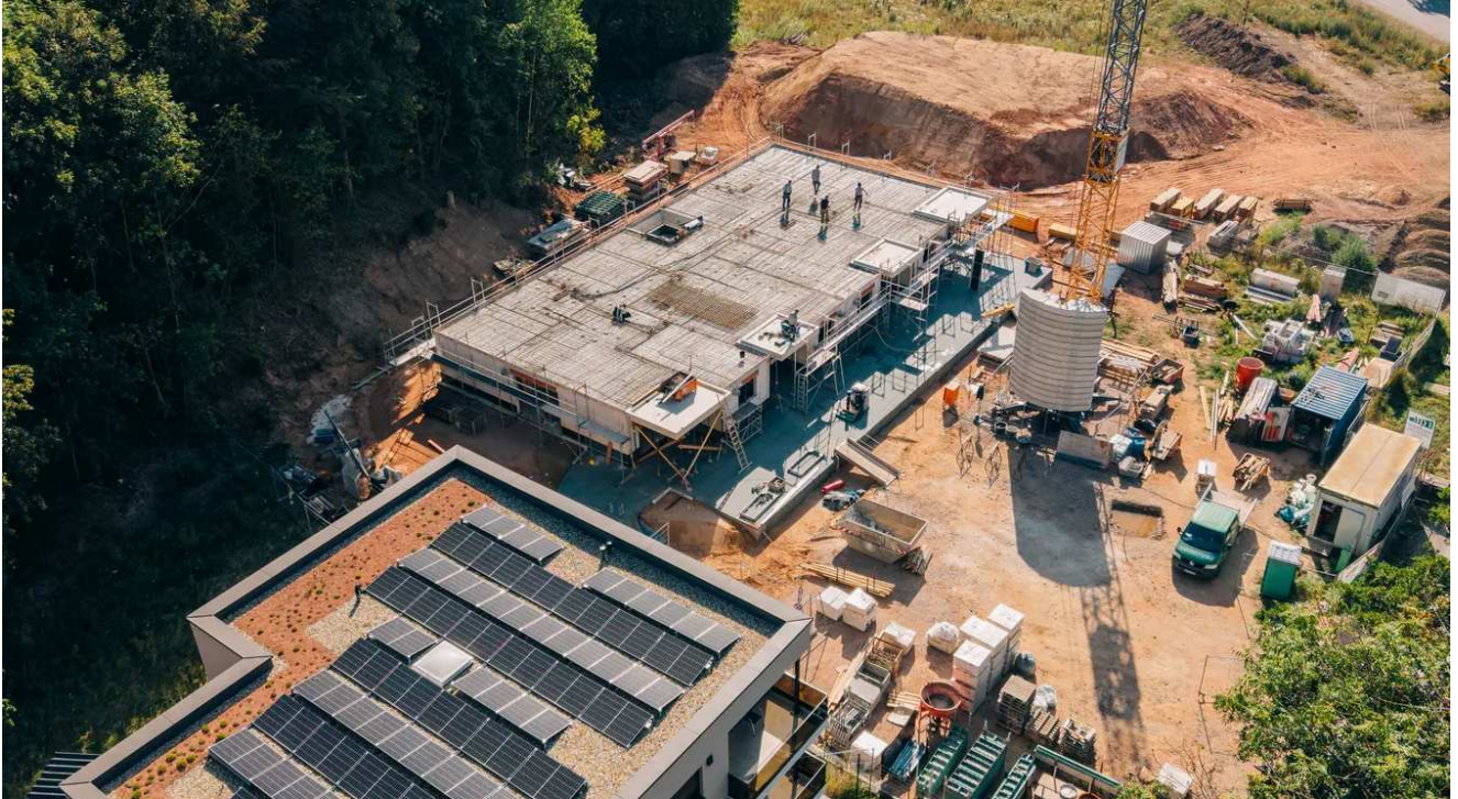
Juli 2026. Blick über das Baufeld Richtung Weiden. Im Vordergrund das fertiggestellte Nachbargebäude mit Photovoltaik auf dem Dach. Foto: Luca Donth
