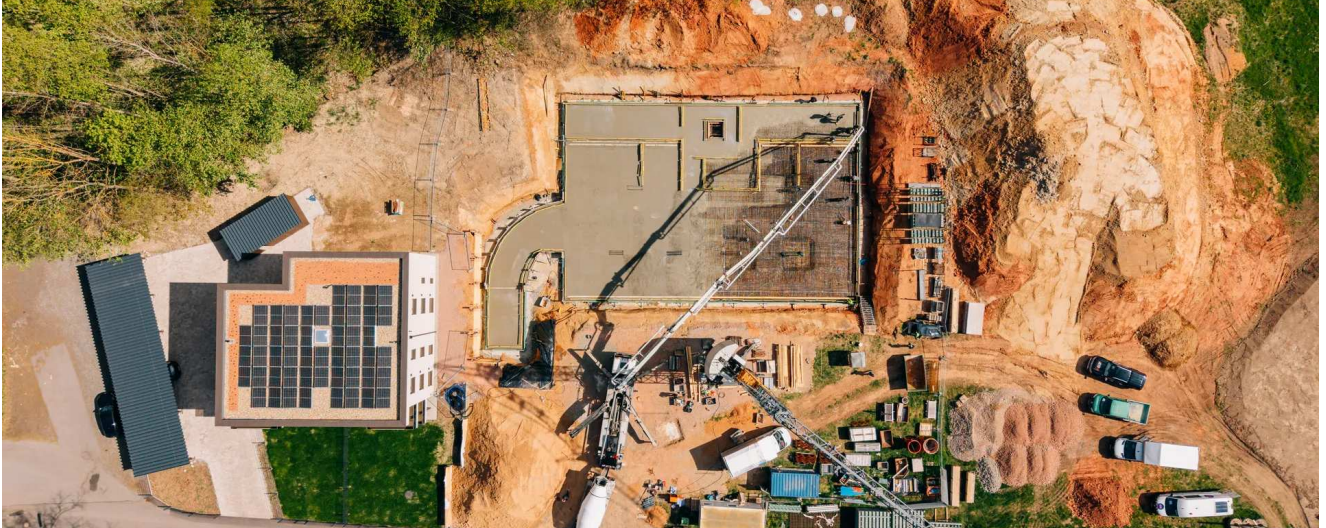
28. April 2026. Die fertig betonierte Bodenplatte im Baugrund, über 200 m 3 Beton in einer Schicht. Foto: Luca Donth
