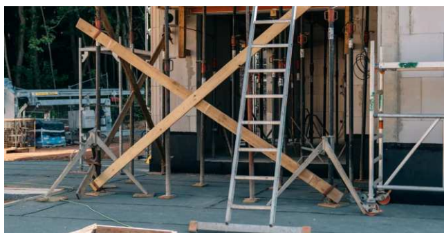
Schalung und Bewehrung für die nächste Geschossdecke.
