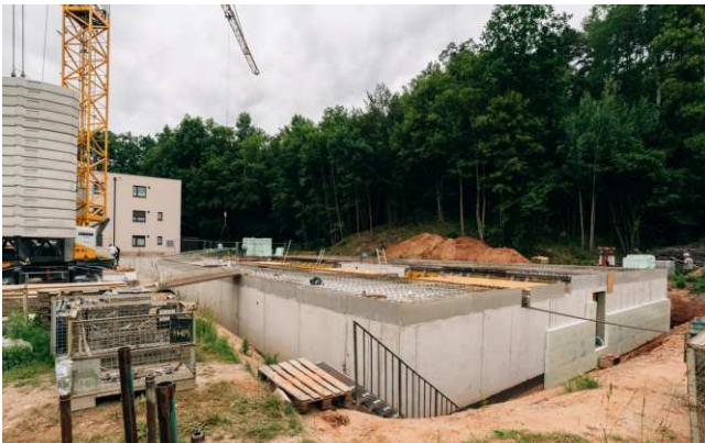
Juni 2026. Die Untergeschosse stehen, der Turmdrehkran ist gesetzt.
