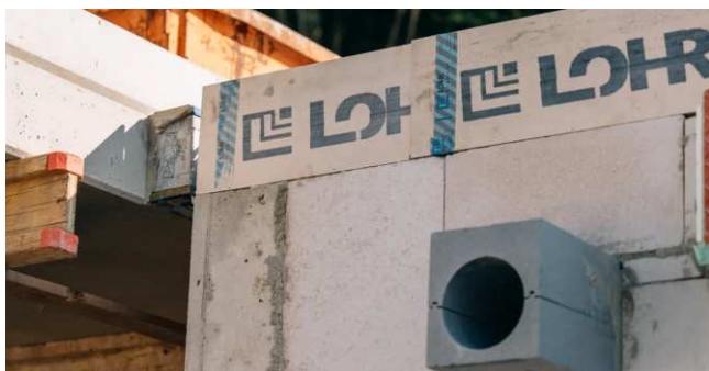
Fertigteilewand mit vorbereiteter Durchführung für die dezentrale Lüftung.
