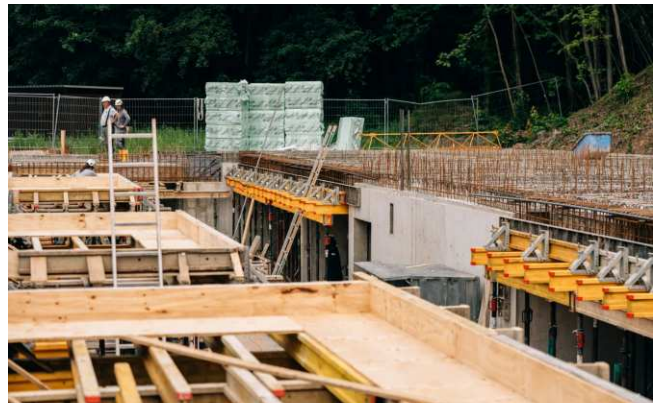
Juni 2026. Schalung und Bewehrung für die Decke über der Tiefgarage.
