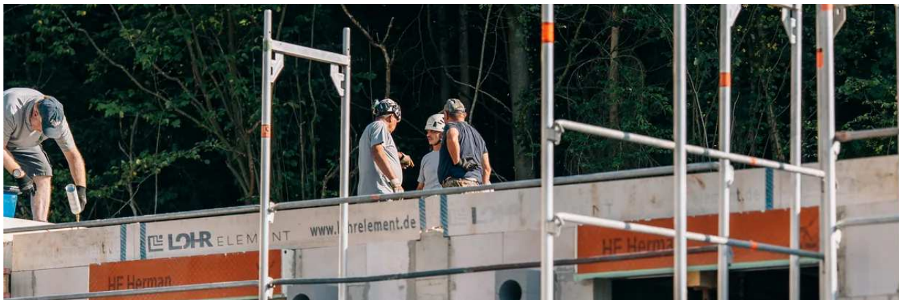
Juli 2026. Die Wände des Erdgeschosses sind gesetzt, das Gerüst steht rundum. Foto: Luca Donth
