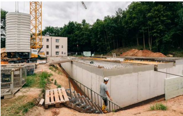
Juni 2026. Die Kellerwände aus Ortbeton, rechts die vorbereitete Decke.
