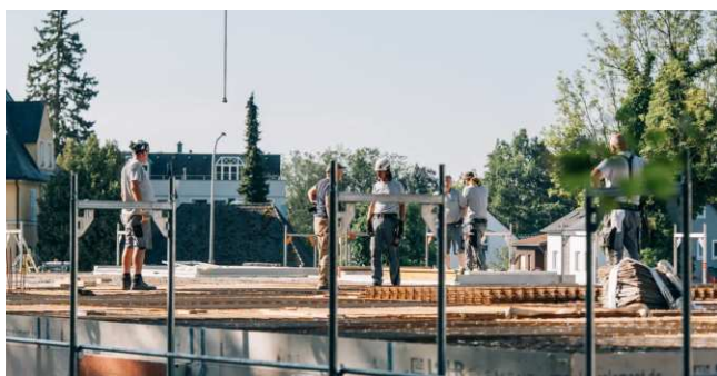
Arbeiten auf der Geschossdecke, Fensteröffnungen sind bereits gesetzt.
